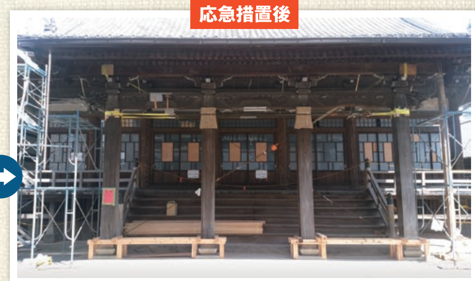
歪みにより礎石から外れた本堂向拝柱の応急措置
